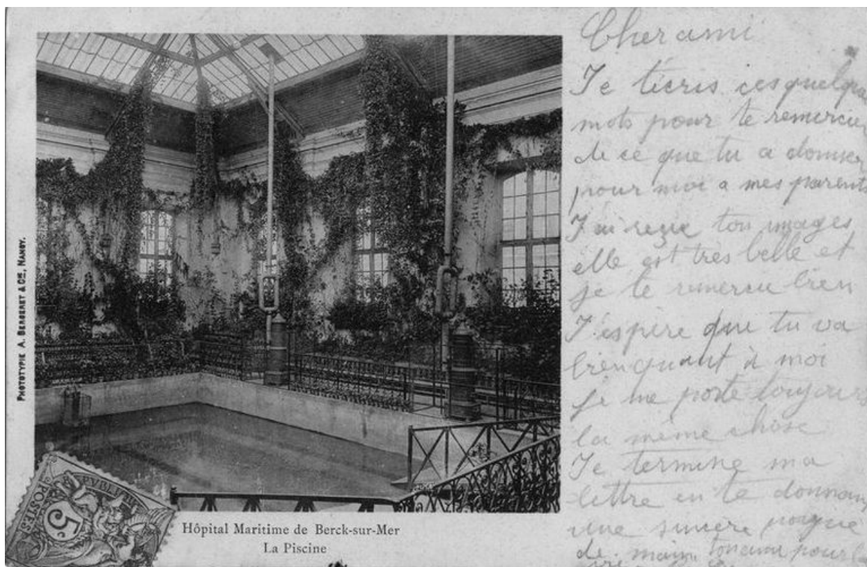
Piscine couverte d'eau de mer, vue intérieure.
