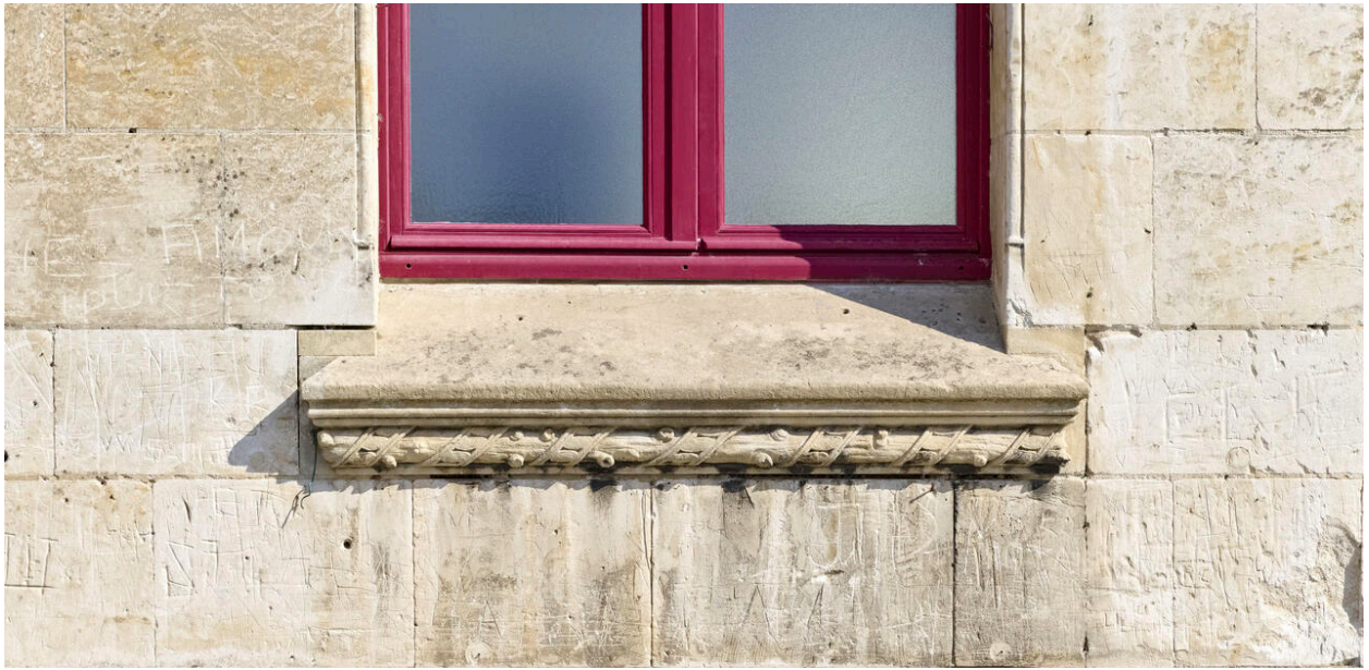
Détail du décor de branche en appui de fenêtre de la façade ouest du beffroi.
