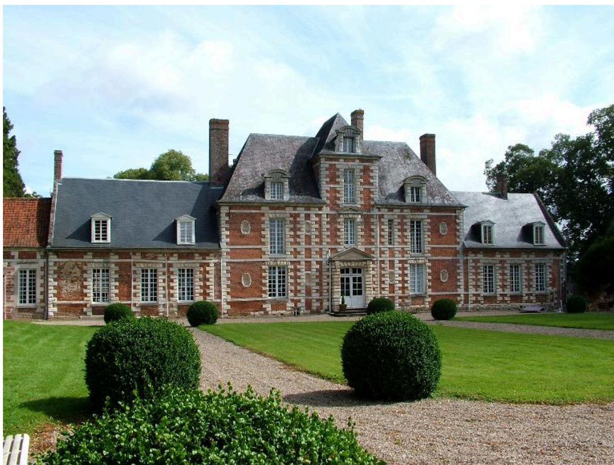
Elévation du logis sur jardin.
