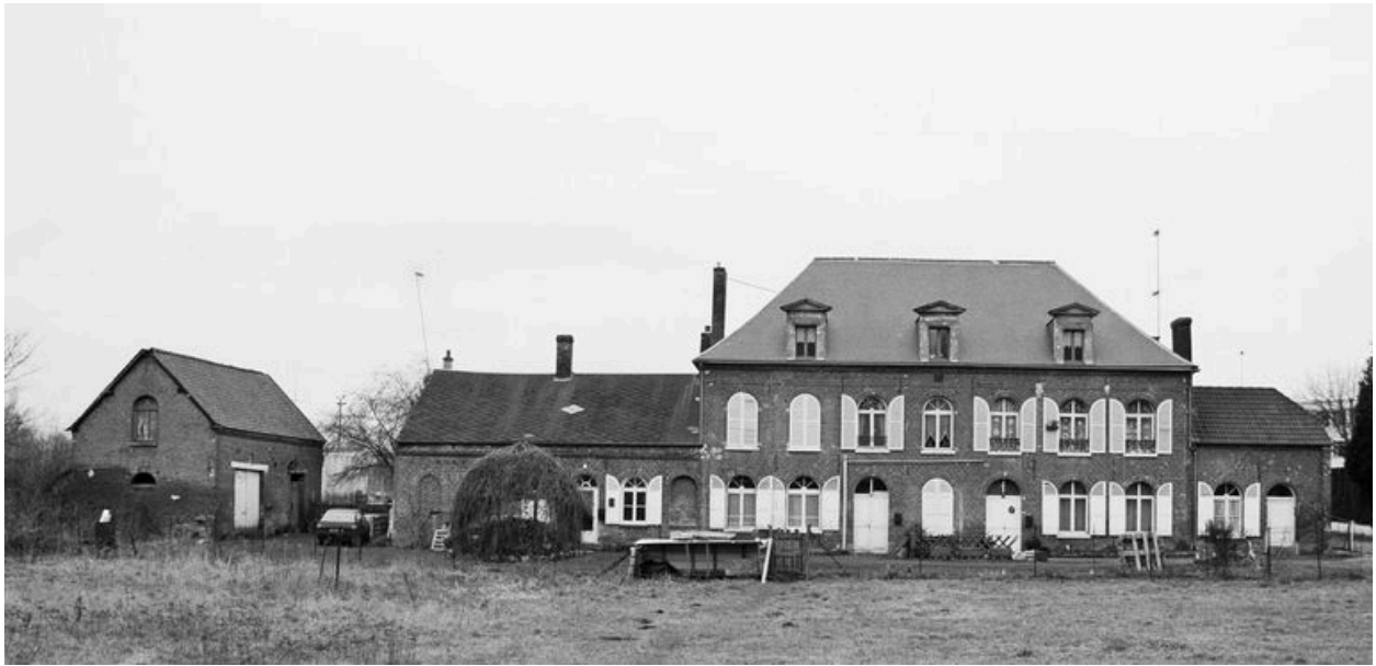
Logement patronal et bureaux : façade postérieure.
