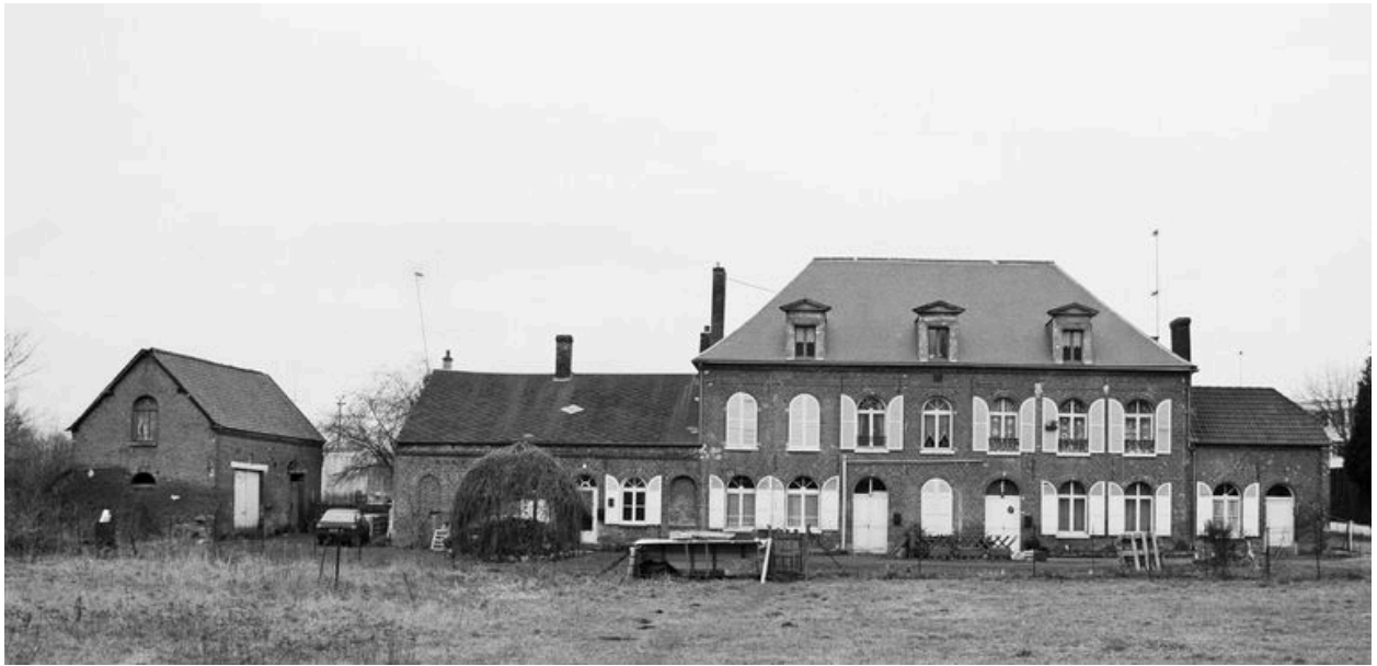
Logement patronal et bureaux : façade postérieure.
