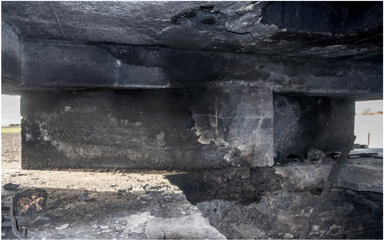
Vue intérieure des embrasures de tir nord-est et sud-ouest
