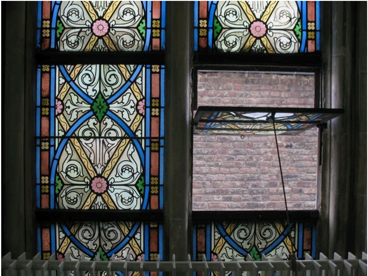
Vue de détail, baie 13
