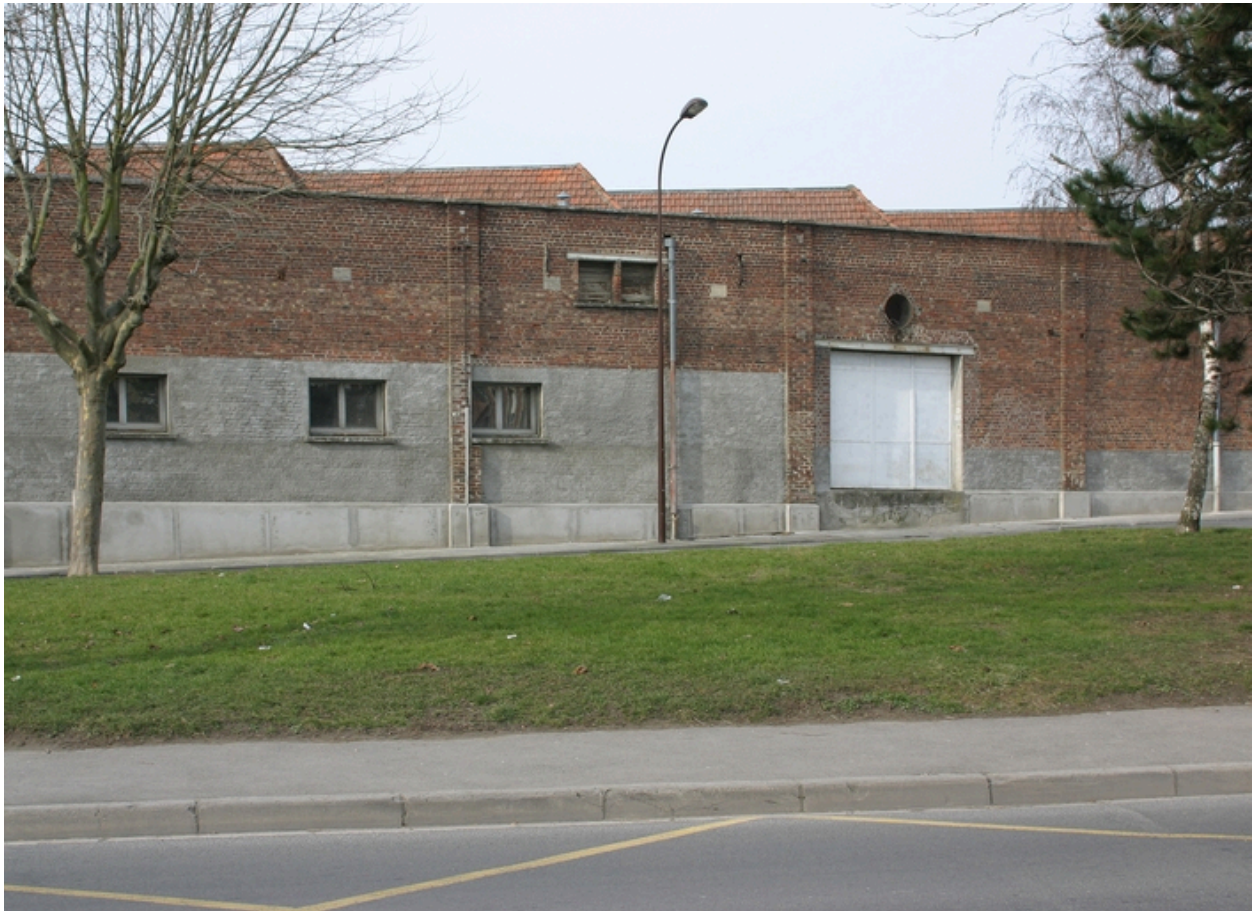
Façade des ateliers de 1921, rue Ribaudois.
