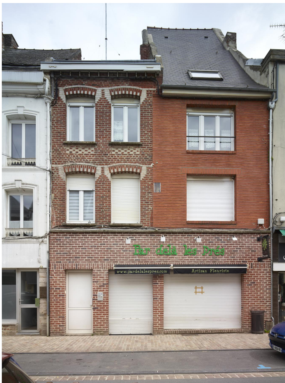
Maison - 14-16, rue Thiers. Seule la partie droite de la façade date de la Seconde Reconstruction.
