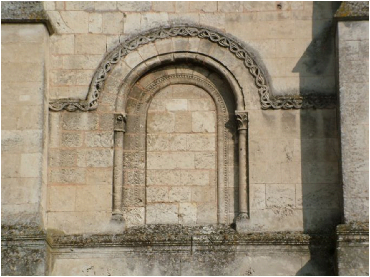
Fausse-fenêtre au premier niveau de la tour-clocher.
