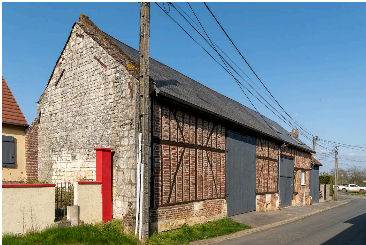
Ancienne grange sur rue avec entrée charretière, n°11 rue de la Mairie, vue depuis le sud-ouest.
