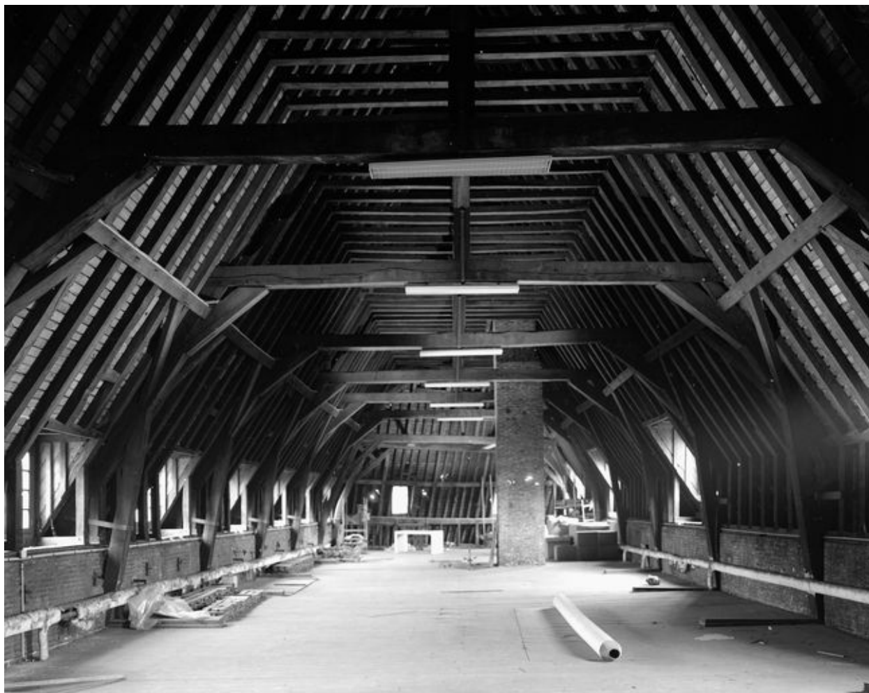
Bâtiment de la communauté religieuse, comble, vue générale.
