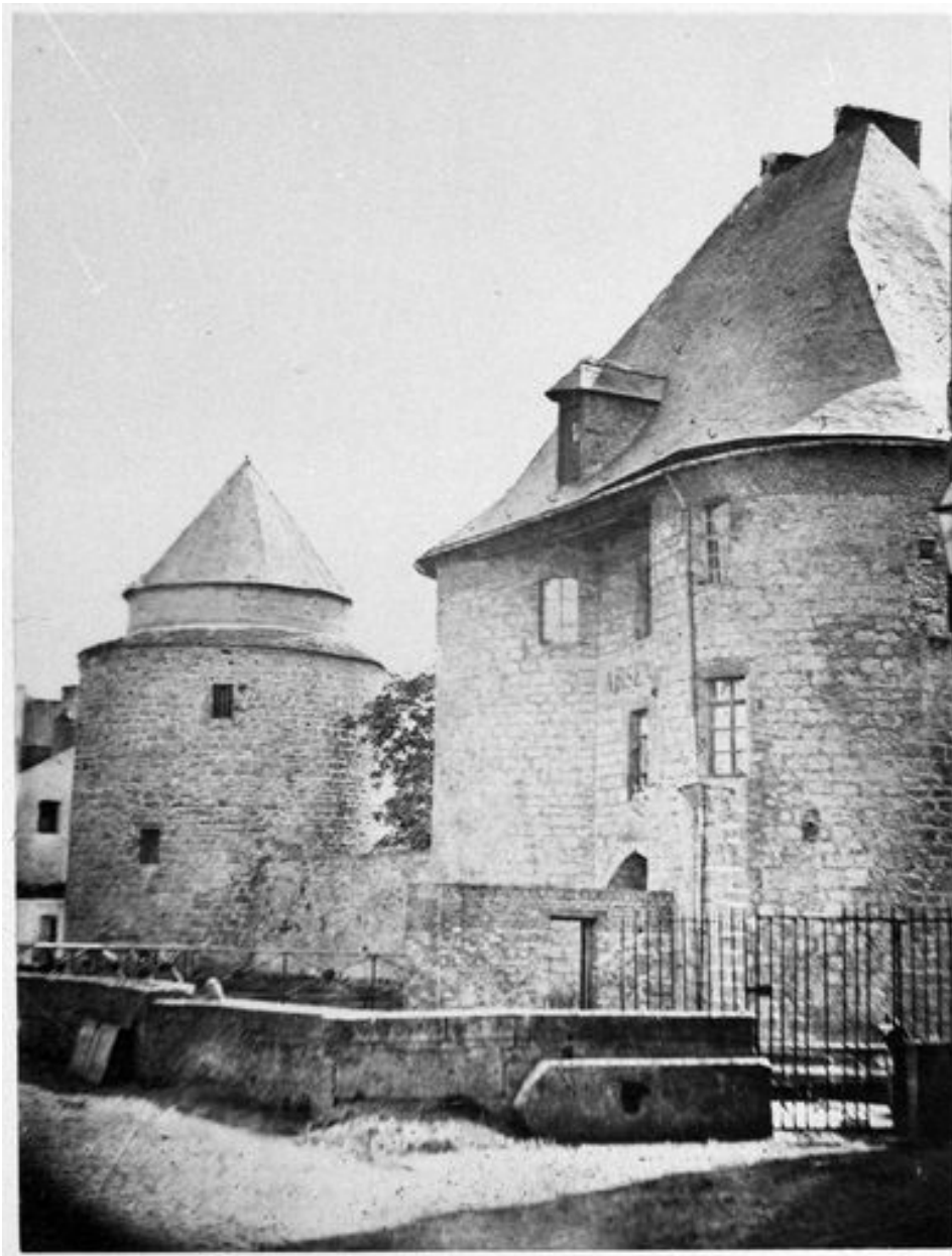
Front nord (rue de l' Arsenal) : vue en enfilade depuis le nord-ouest avec en premier plan l'ouvrage d'entrée puis la courtine et la tour d'angle nord-est, vers 1900 (AD Nord).
