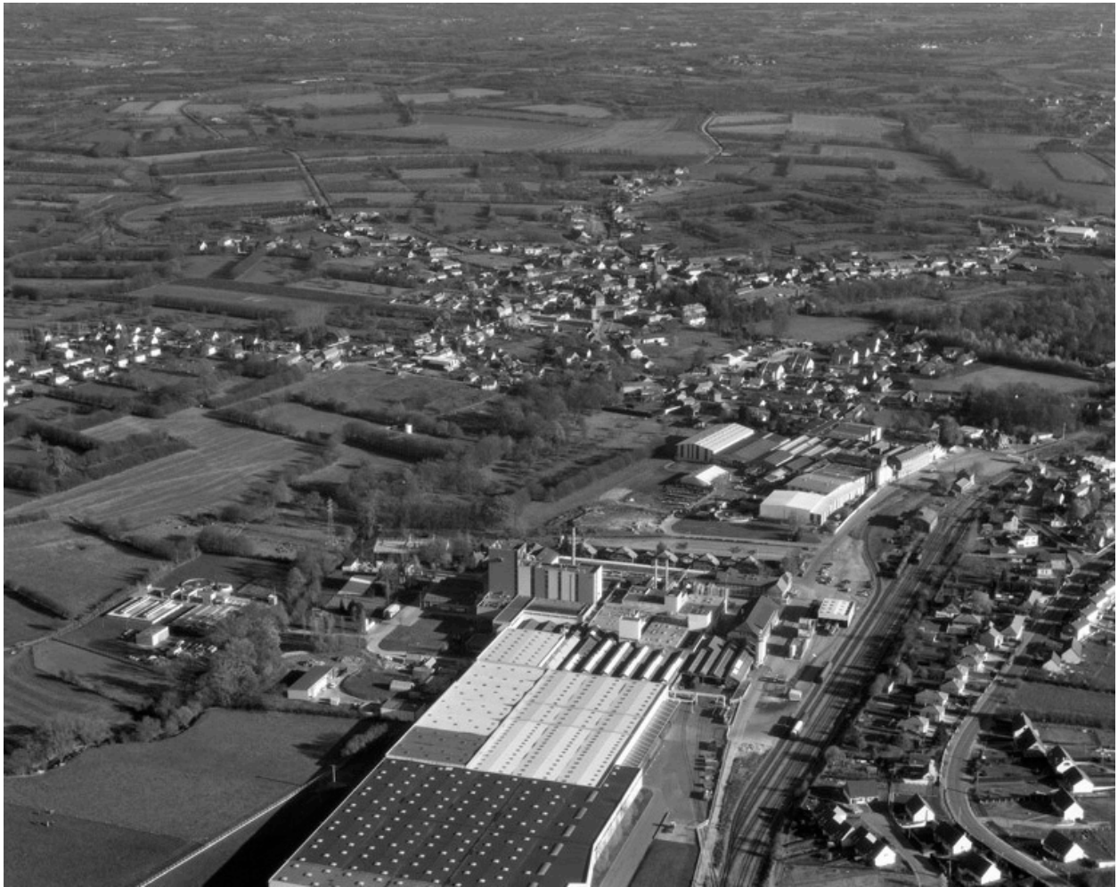
Vue aérienne de l'usine, depuis l'ouest.
