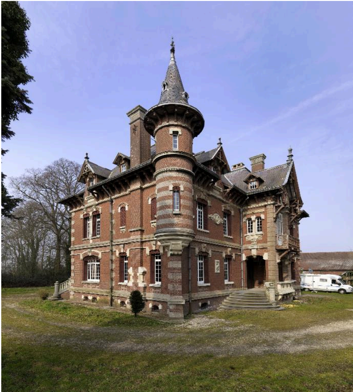
Vue de trois-quarts sud-ouest.
