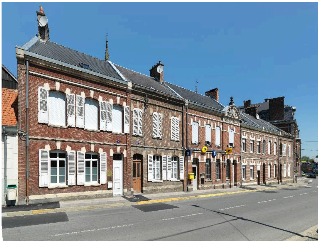
Vue d'ensemble de la façade sur rue, vers l'est.
