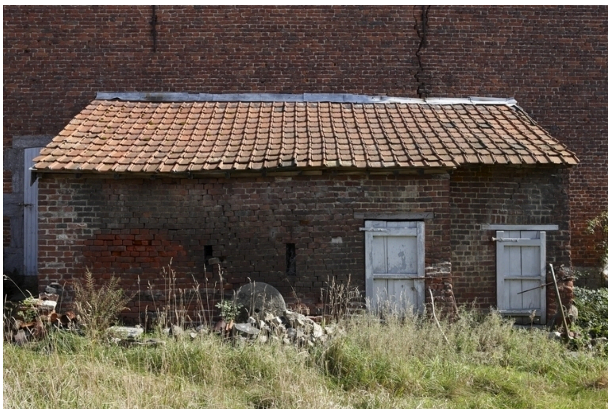
Détail de la porcherie accolée à la grange.
