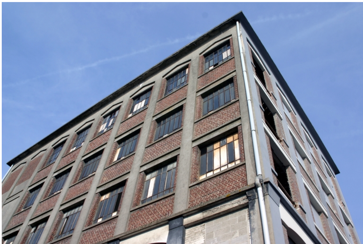
Angle sud-est de la minoterie.
