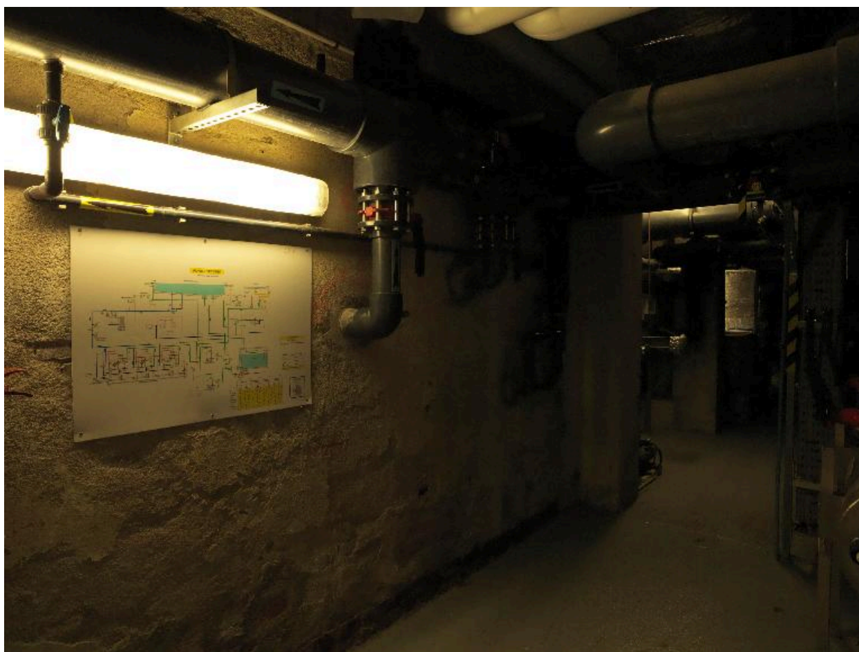
Entrée des locaux techniques en sous-sol.
