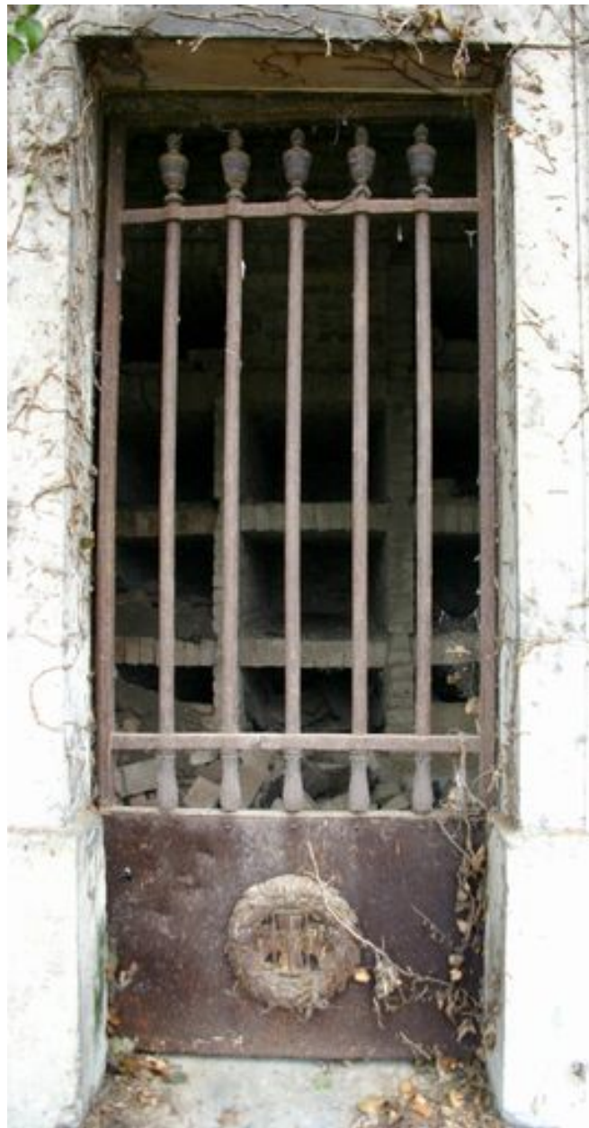
Vue de détail sur la porte en fonte.
