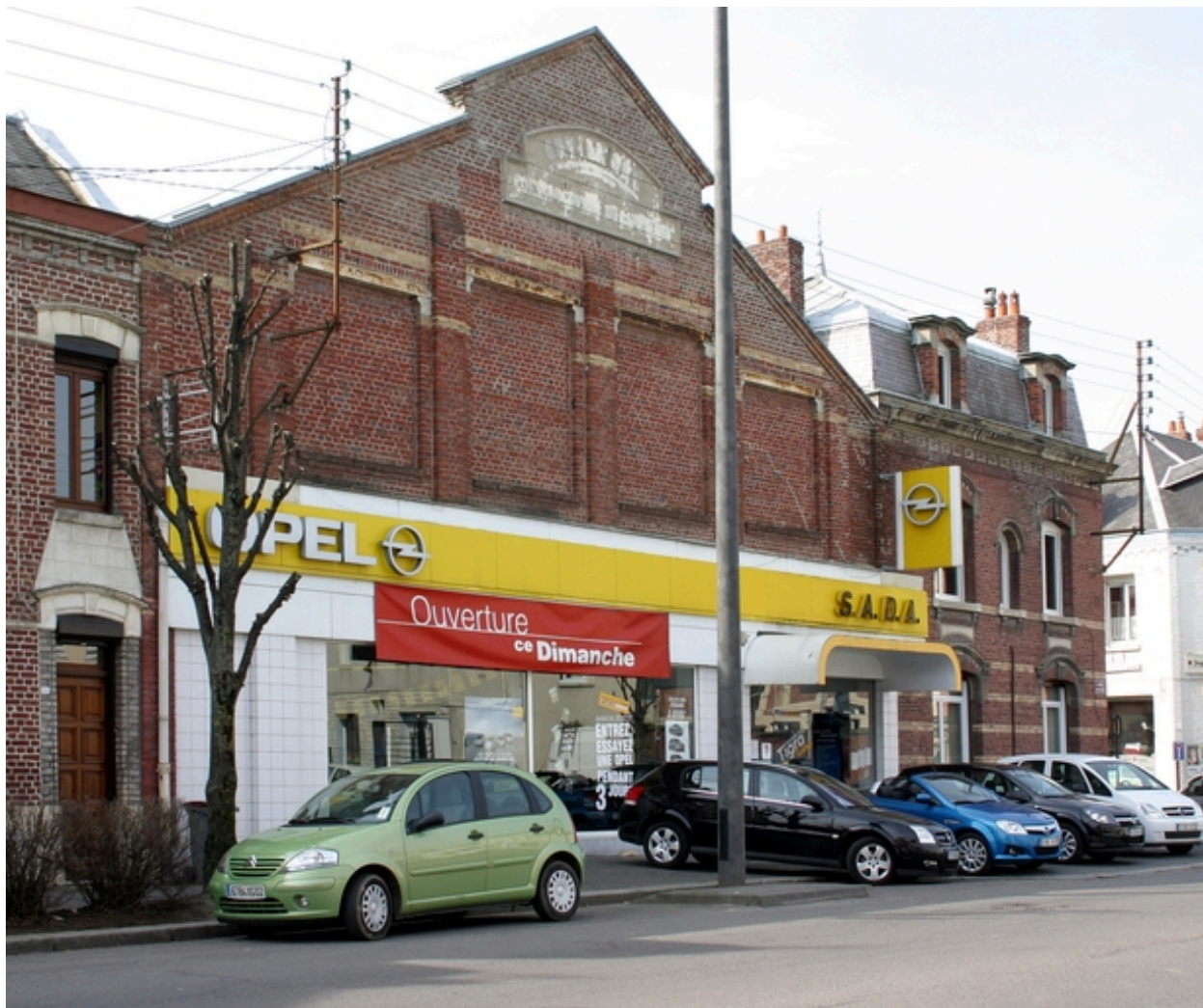
Façades antérieures des ateliers et du logement patronal, boulevard Victor-Hugo.
