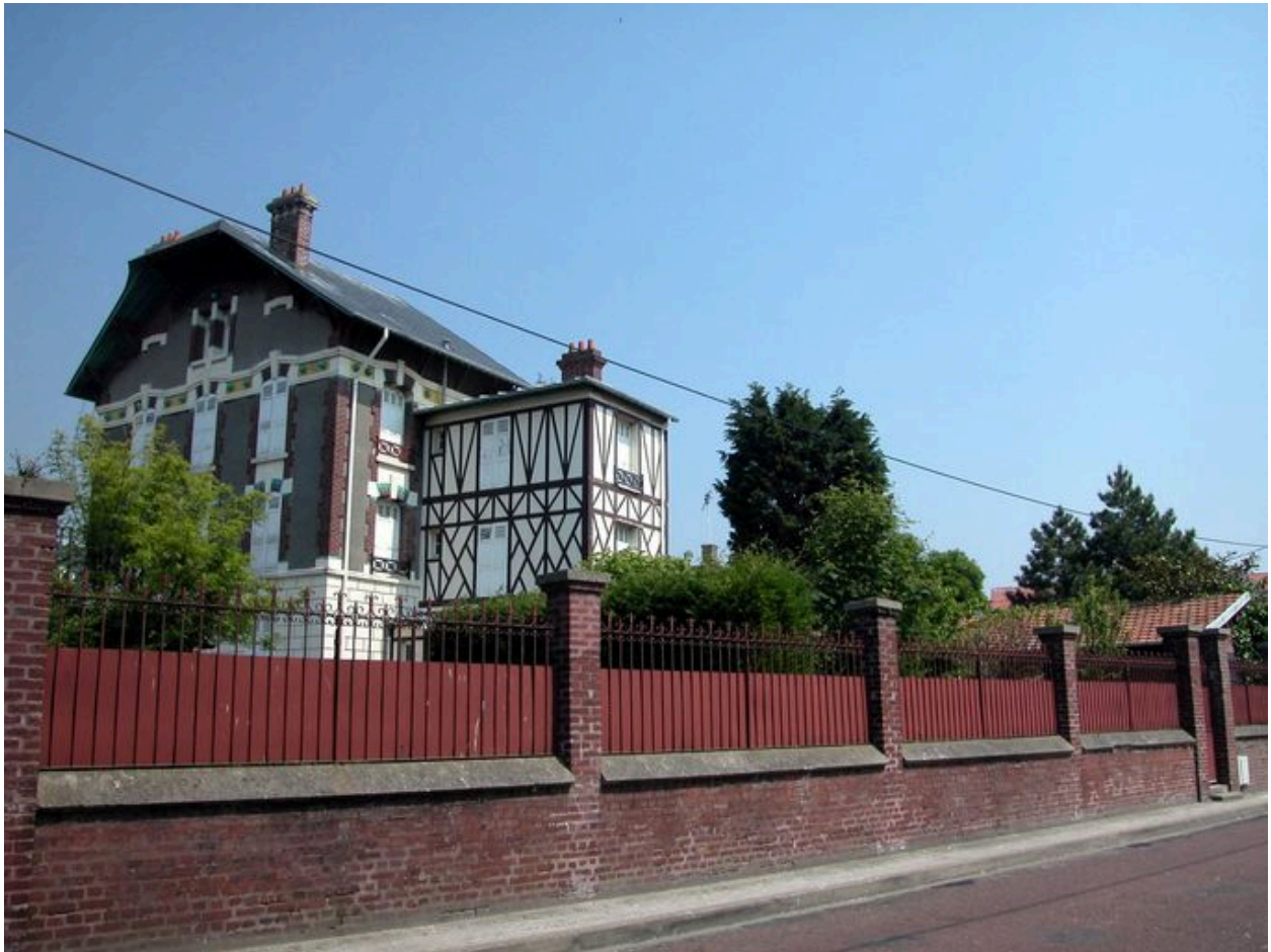
Vue d'ensemble de la maison et sa clôture, depuis la rue Mennessier.
