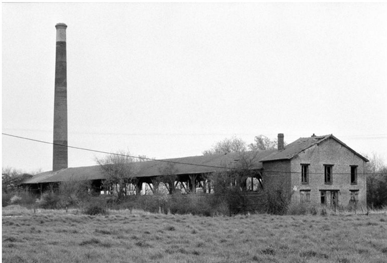
Atelier de fabrication, flanc sud-est.
