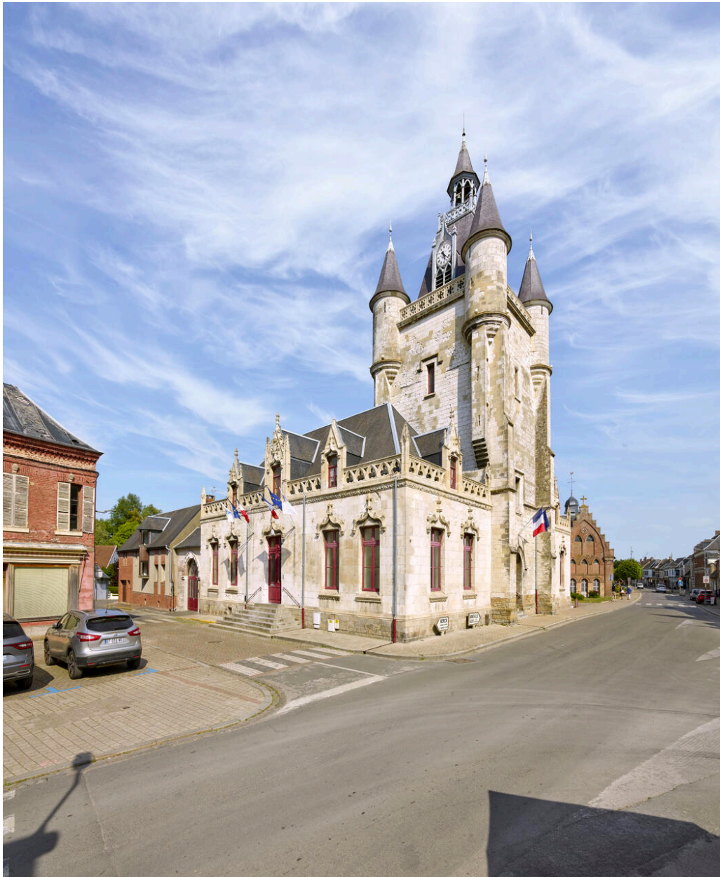
Vue d'ensemble sud-ouest du beffroi.
