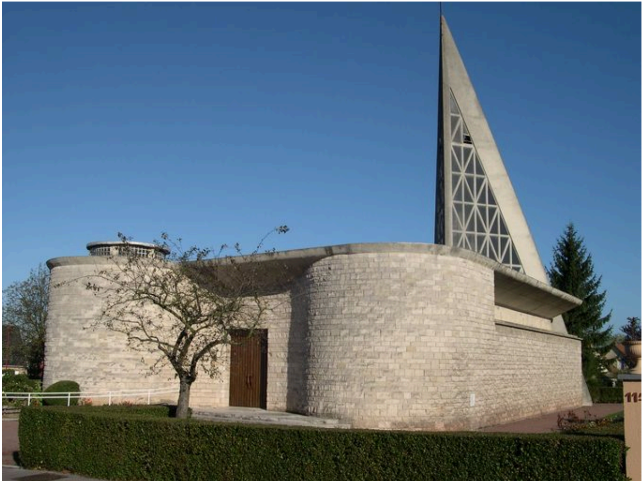
Vue depuis le sud-est.
