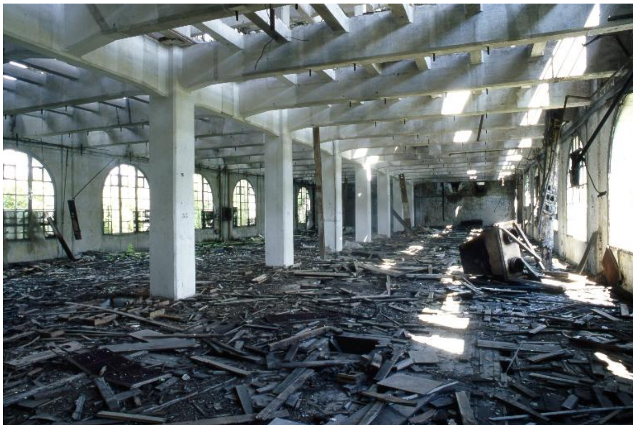
Bâtiment des moulins. Rez-de-chaussée.
