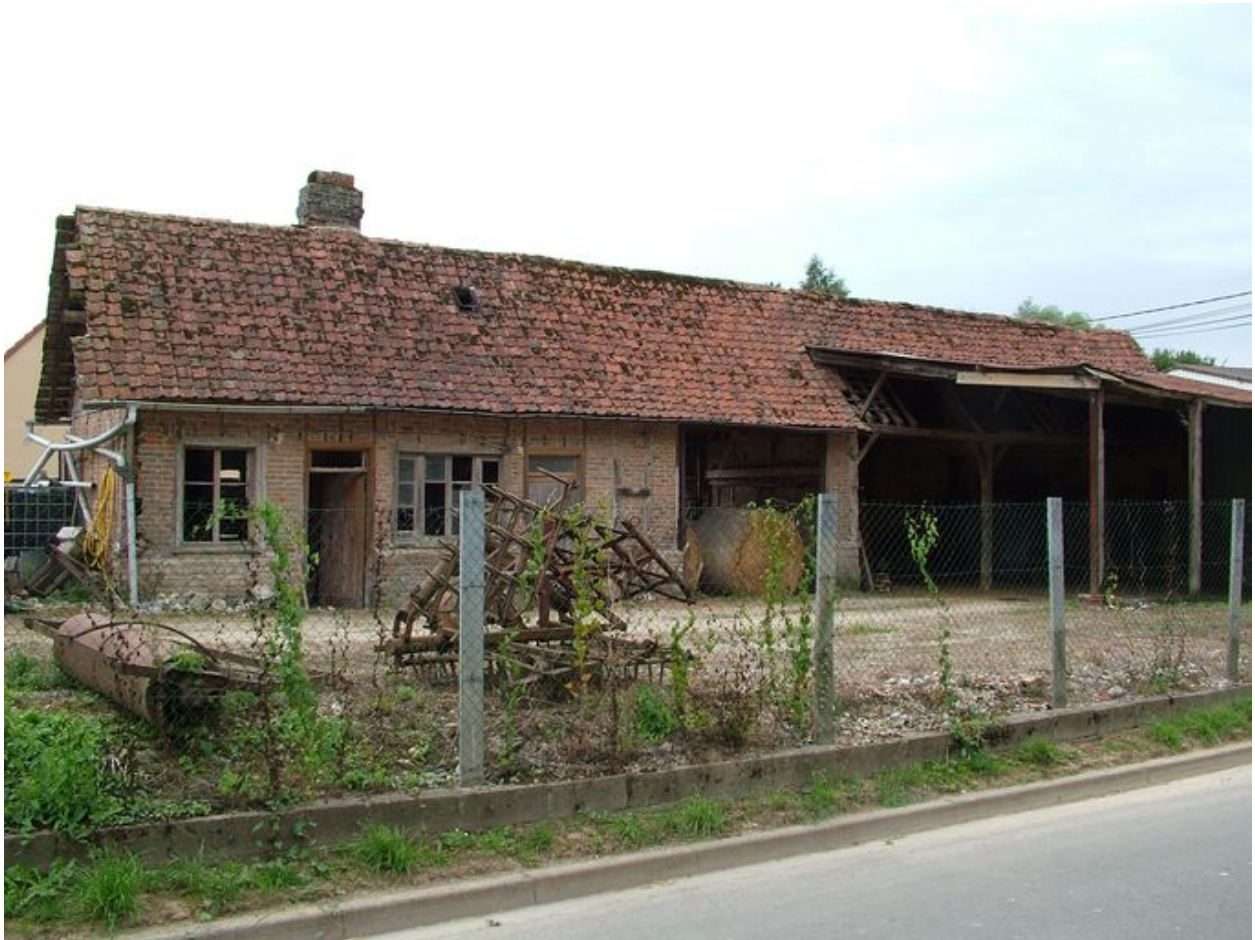
Bouchon, ancienne ferme, 14 rue de Mouflers, 1ère moitié du 19e siècle.
