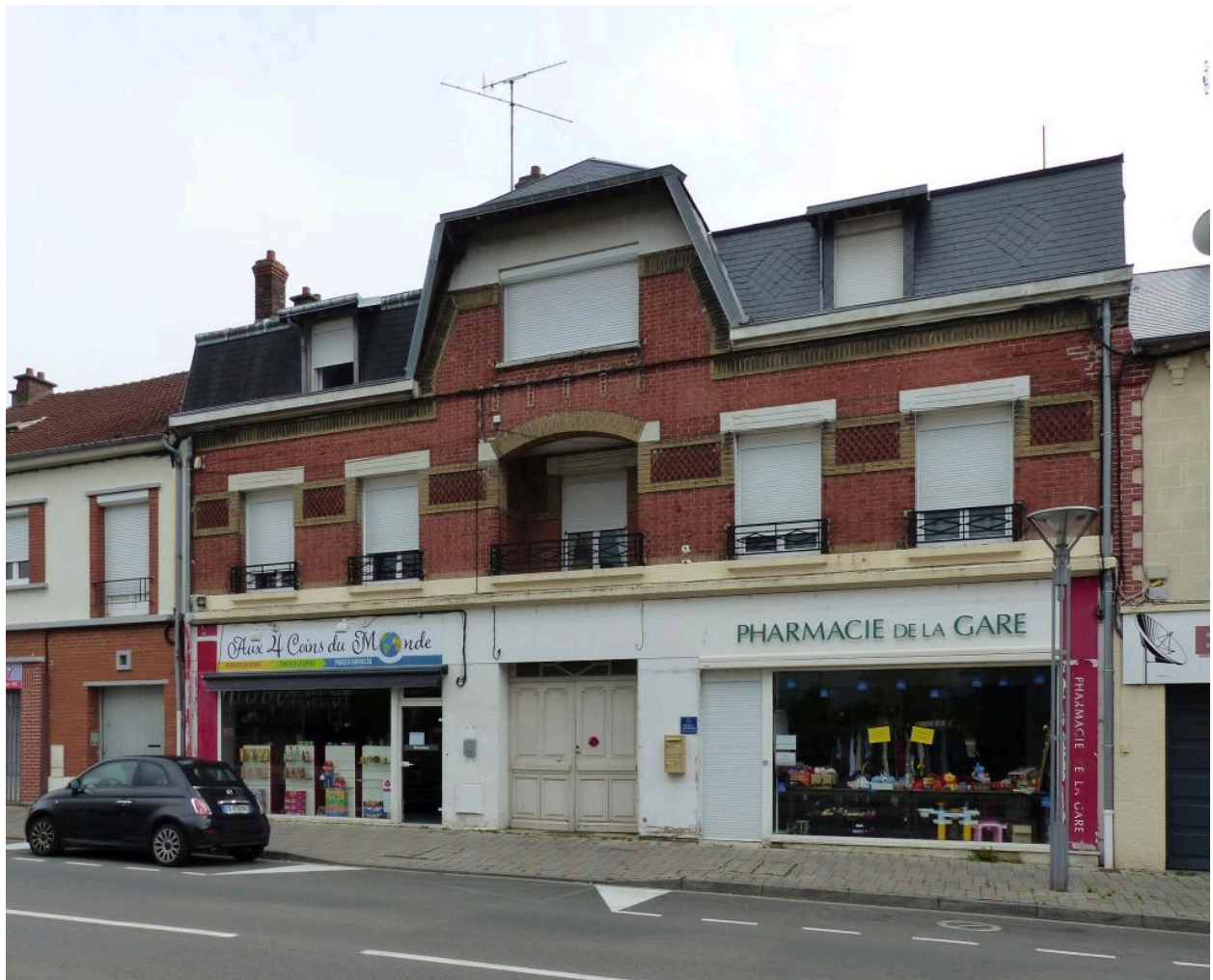
Maison à boutiques, rue Pierre-Sémard.
