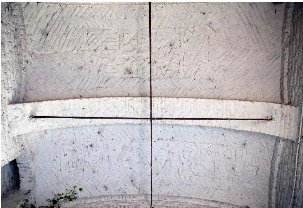
Vue générale des voûtes du pigeonnier-porche de la ferme 14 rue Poincaré.
