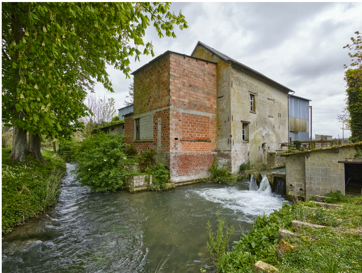
Vue de l'ancien moulin, depuis l'ouest.
