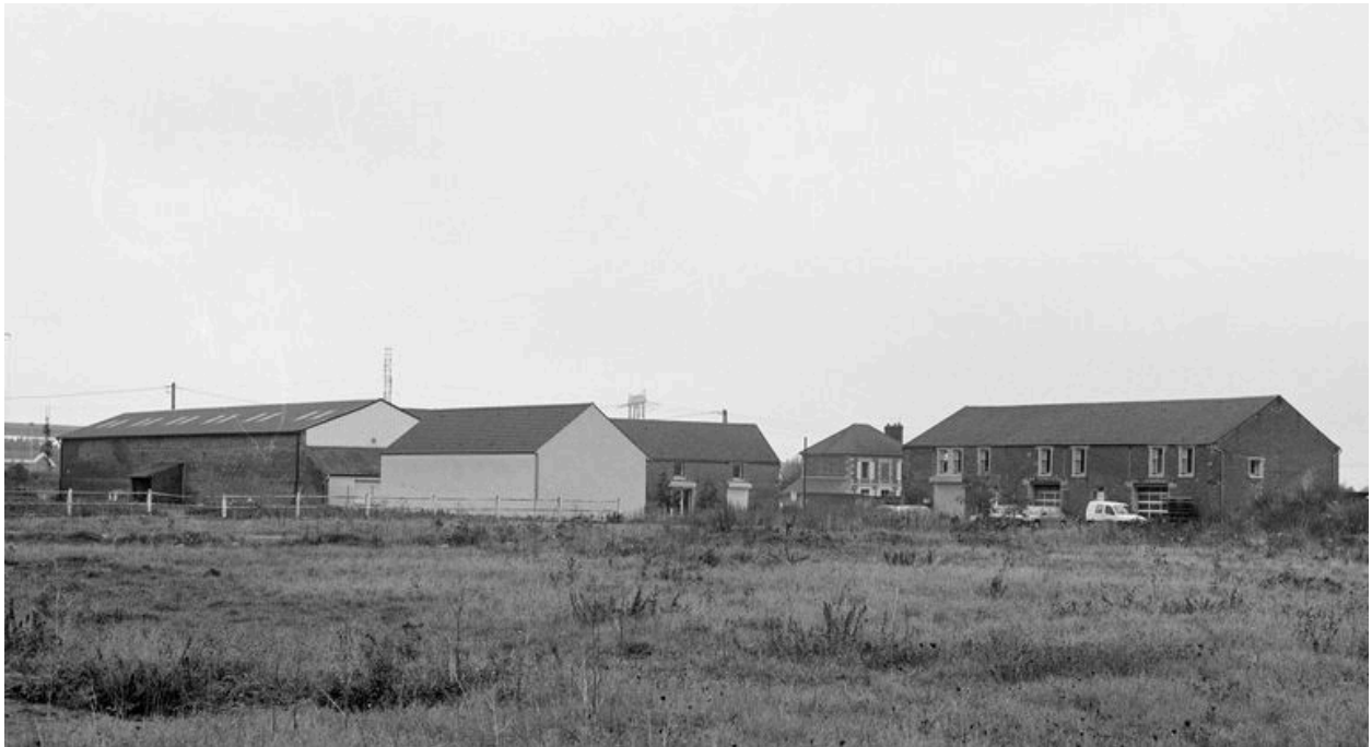
Vue générale des bâtiments subsistant de l'ancienne sucrerie Peters.
