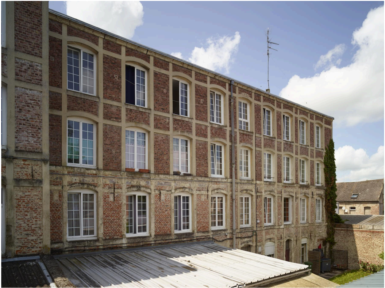
Vue de la façade de l'aile en retour d'équerre.
