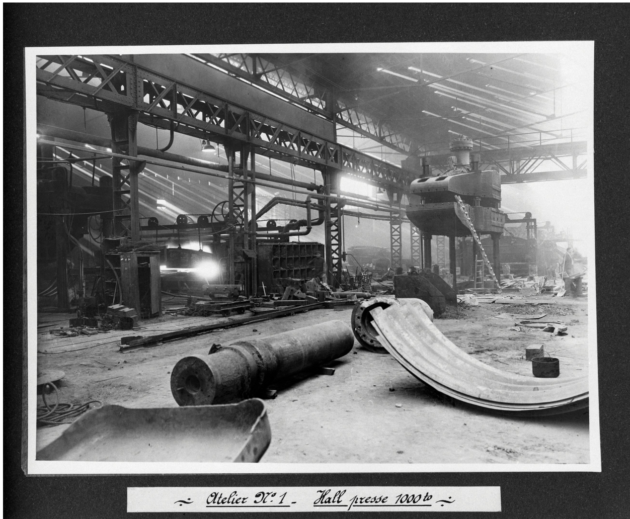
Atelier n° 1 : le hall de presses 1 000 tonnes, 16 février 1940. Photographe inconnu (coll. part., archives Cerec).
