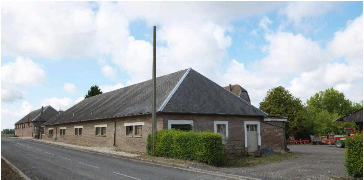
Vue de situation, depuis le nord.
