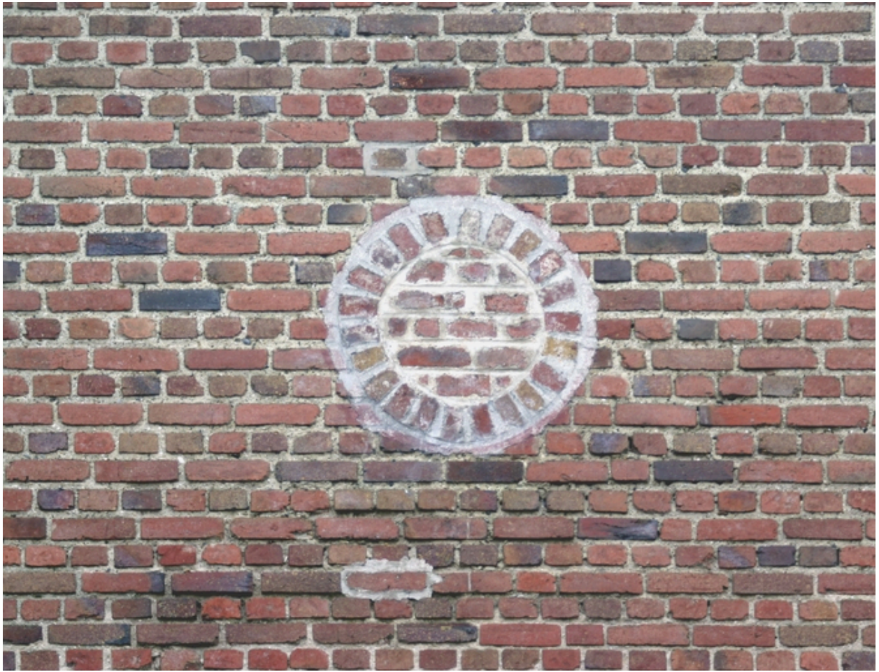
Maçonnerie de brique et ancien oculus.
