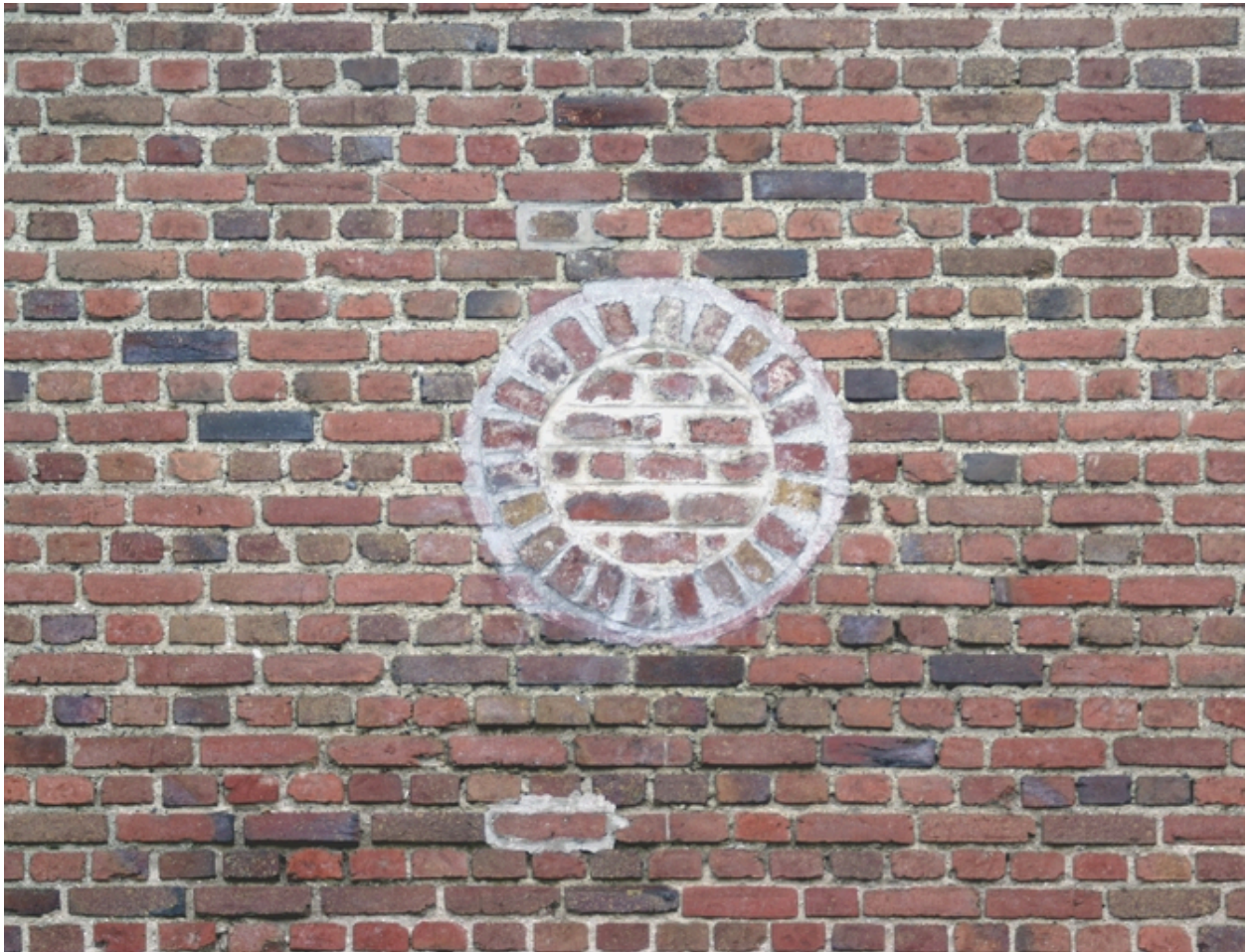
Maçonnerie de brique et ancien oculus.
