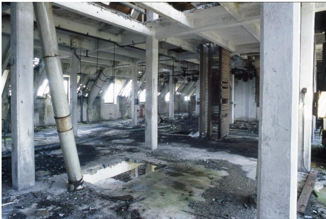
Bâtiment des moulins. Premier niveau de comble.
