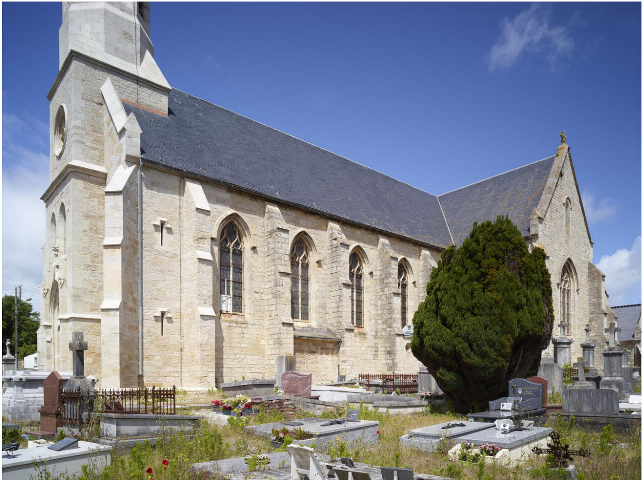
Vue de l'élévation sud.
