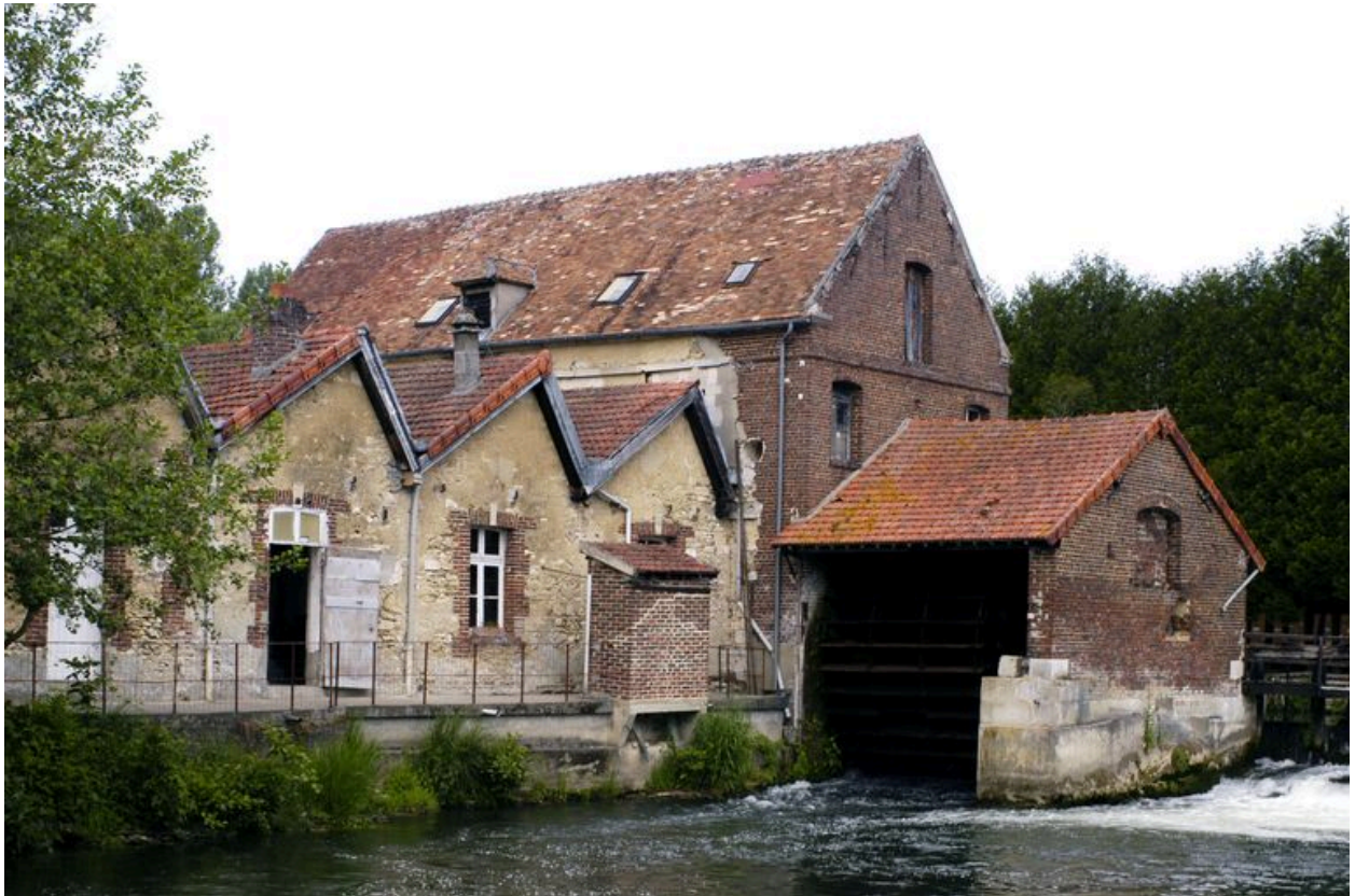
La roue hydraulique et sa cage attenante au pignon du moulin.
