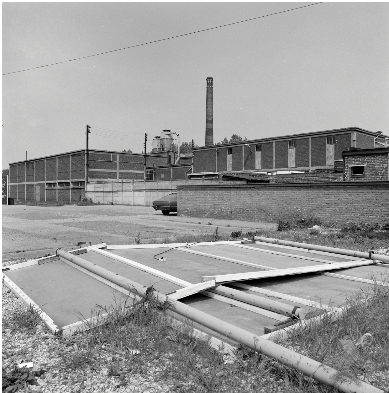
Vue générale vers le nord-est.
