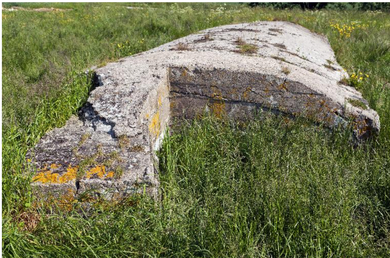
Casemate nord, entrée sud et son mur pare-souffle
