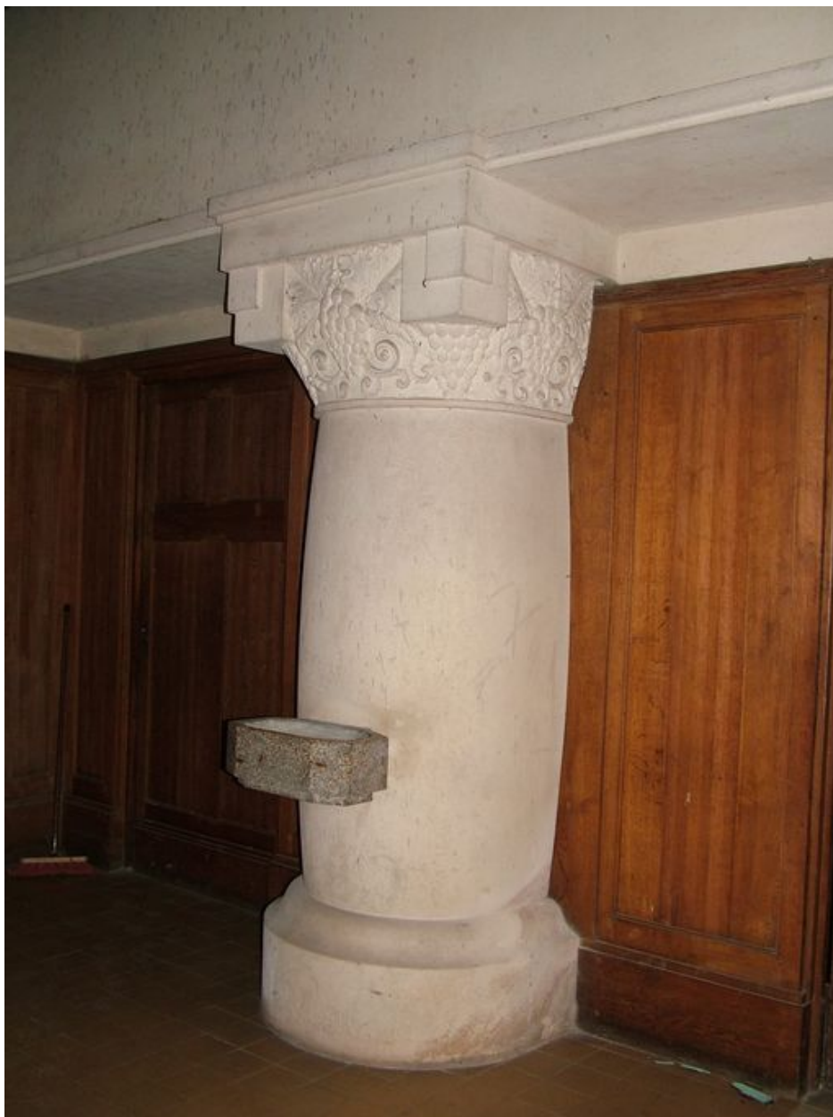
Vue du pilier soutenant la tribune.
