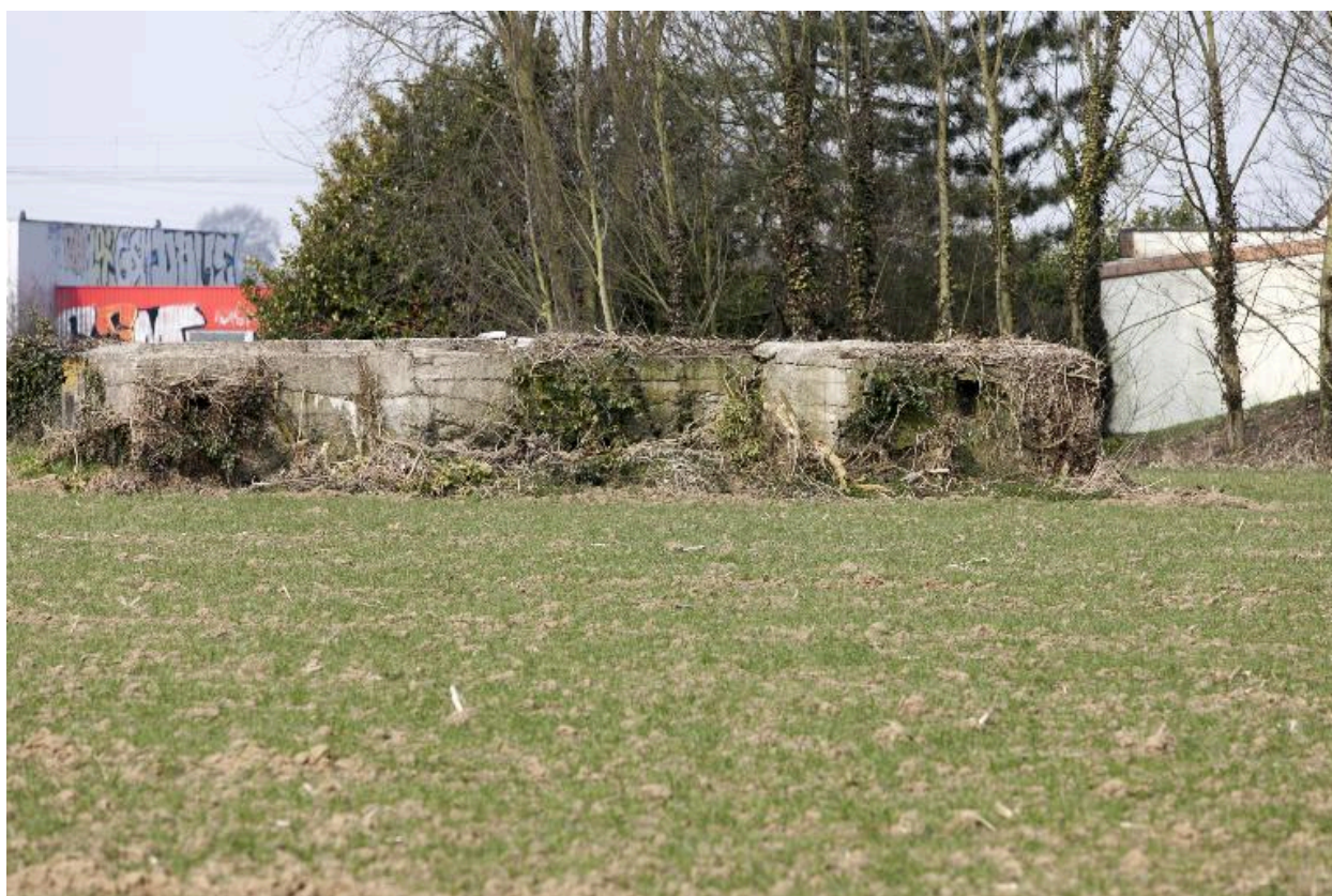
Ouvrage en U
