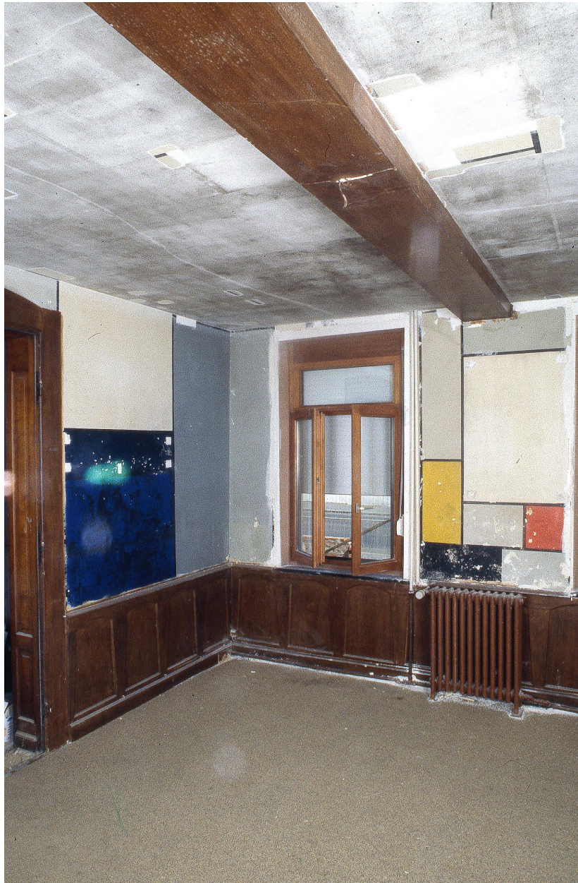
Pièce décorée par Félix Del Marle (1889-1952) : vue générale des murs 1A et 4 en cours de restauration et les sondages du plafond (août 2001).
