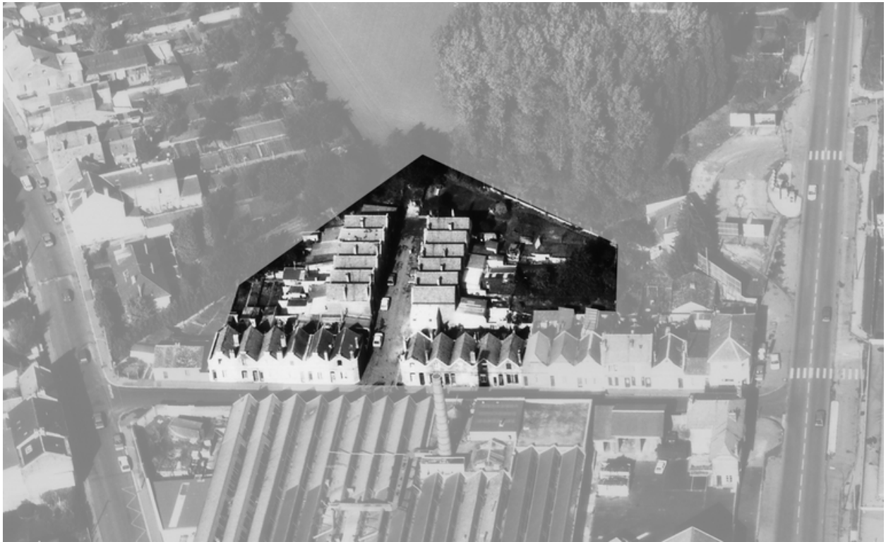
Vue aérienne de la cité en 1989.
