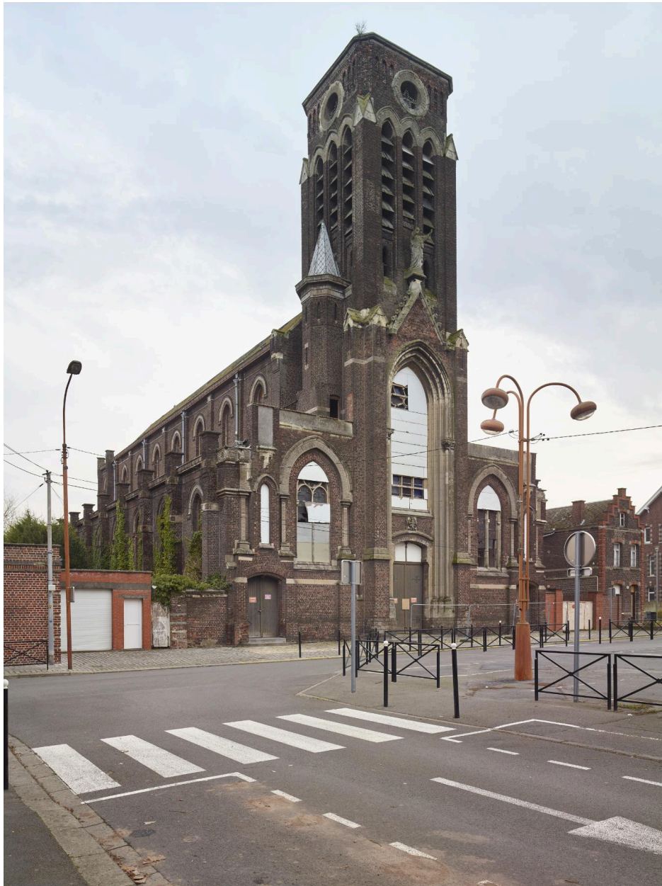
Vue générale de l'église vers l'est.
