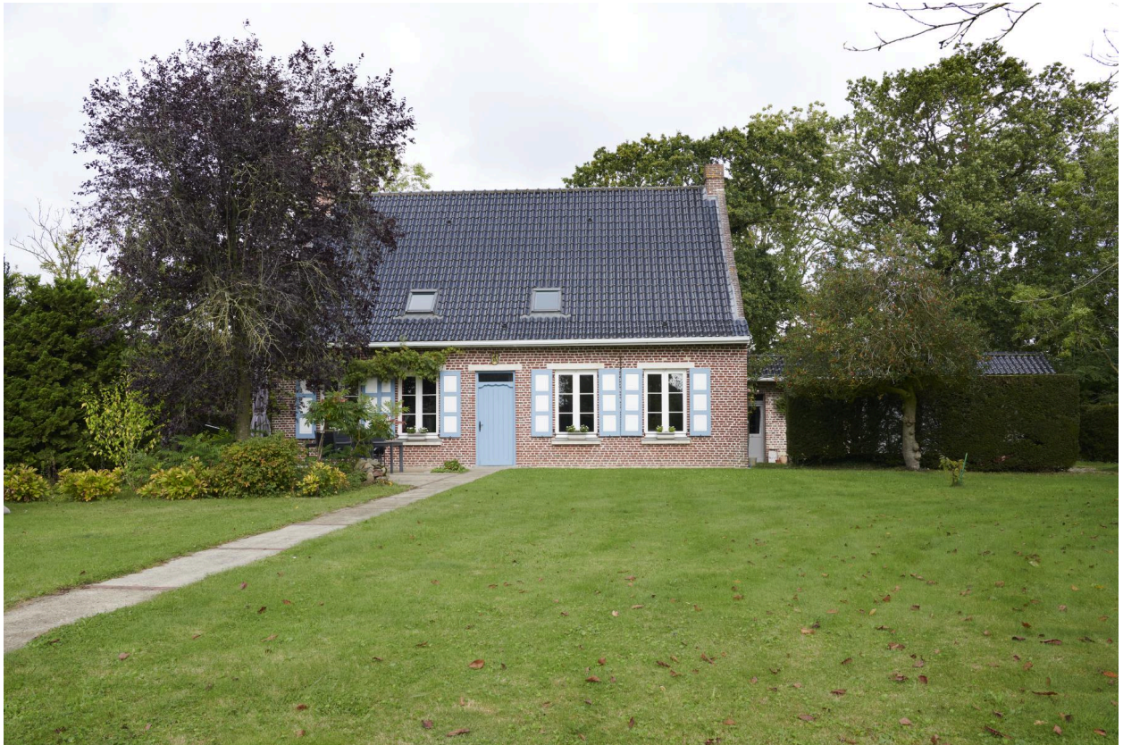
Vue générale de la façade sud.
