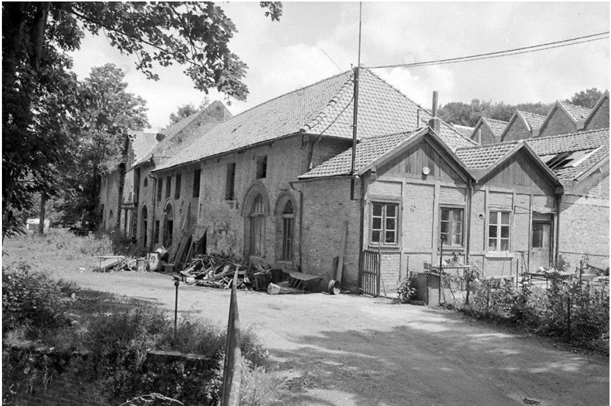
Atelier de fabrication, flanc ouest.
