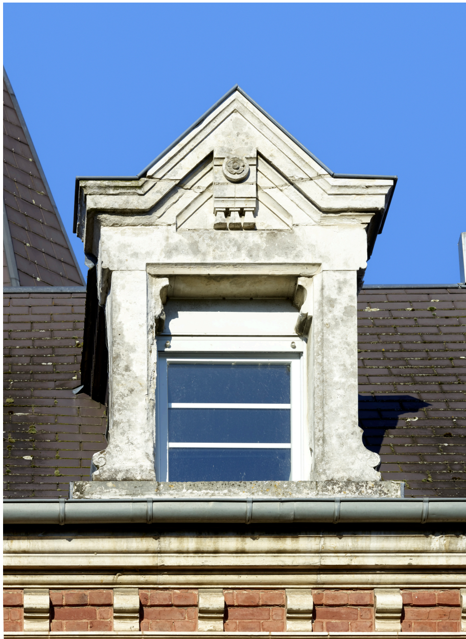
Détail d'une des lucarnes.
