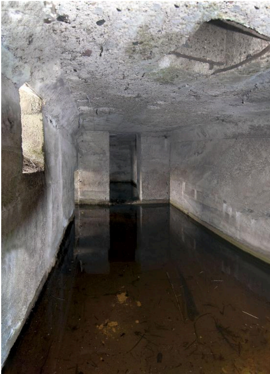
L'intérieur de l'abri, depuis l'entrée nord-est
