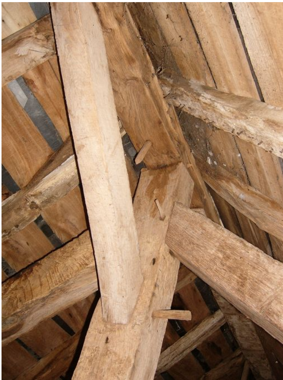
Détail de la charpente.
