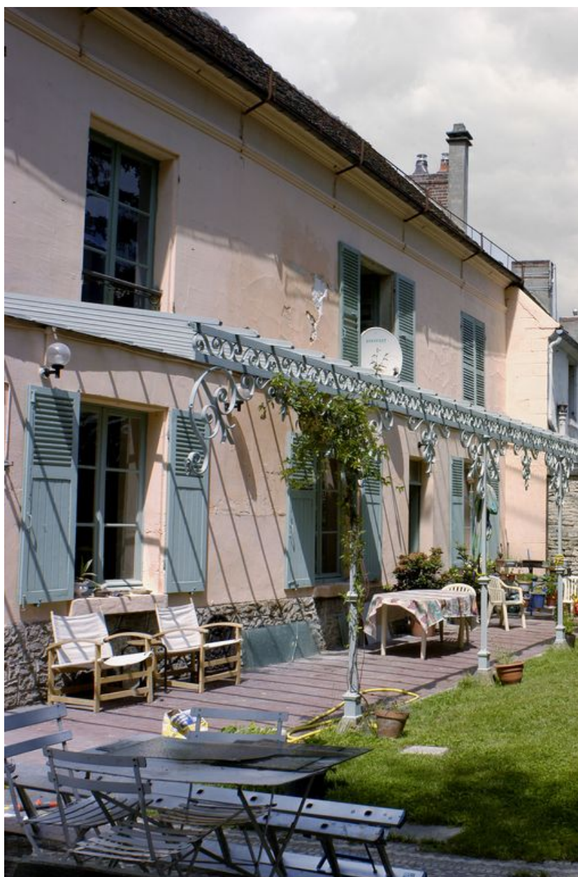
Le logement patronal, façade postérieure.
